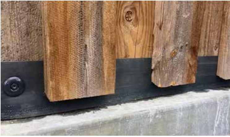
Sikring af beklædnings ender.
