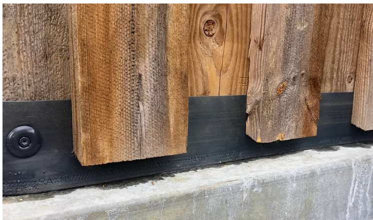
Sikring af beklædnings ender.
