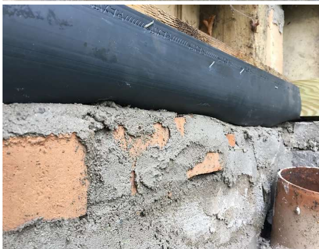
Sikring af svære afslutninger
