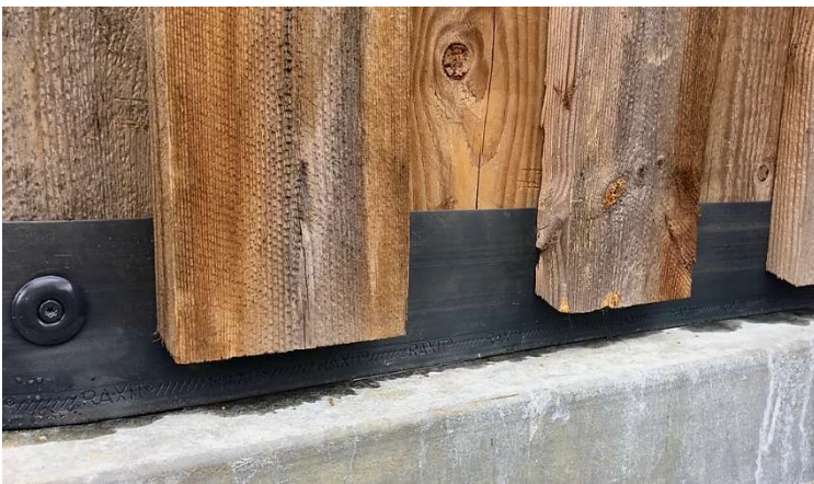
Sikring af beklædnings ender.
