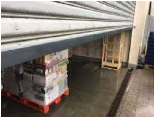
Sikring af port-kanter.
