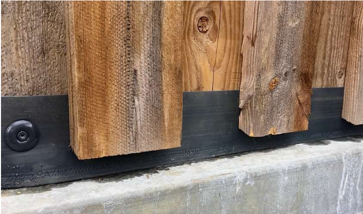
Sikring af beklædnings ender.
